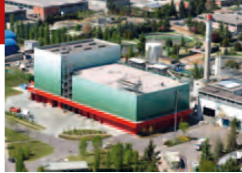
Sopra, la centrale di teleriscaldamento A2A Calore & Servizi a Milano.
