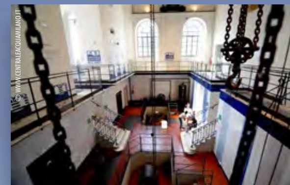
A lato, una sala interna della Centrale dell'Acqua, situata in piazza Dioleziano 5 a Milano.
